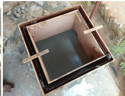
(d) Fig. 4: (d) Concrete filling side wall
